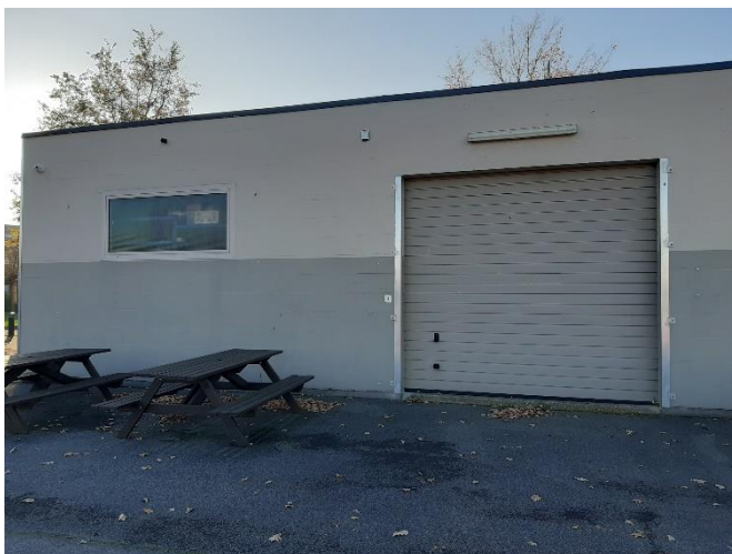
Figuur 6: Berging A.C. Sodibrug atletiekpiste
